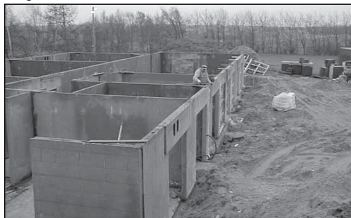
Elementerne er ved at være på plads
