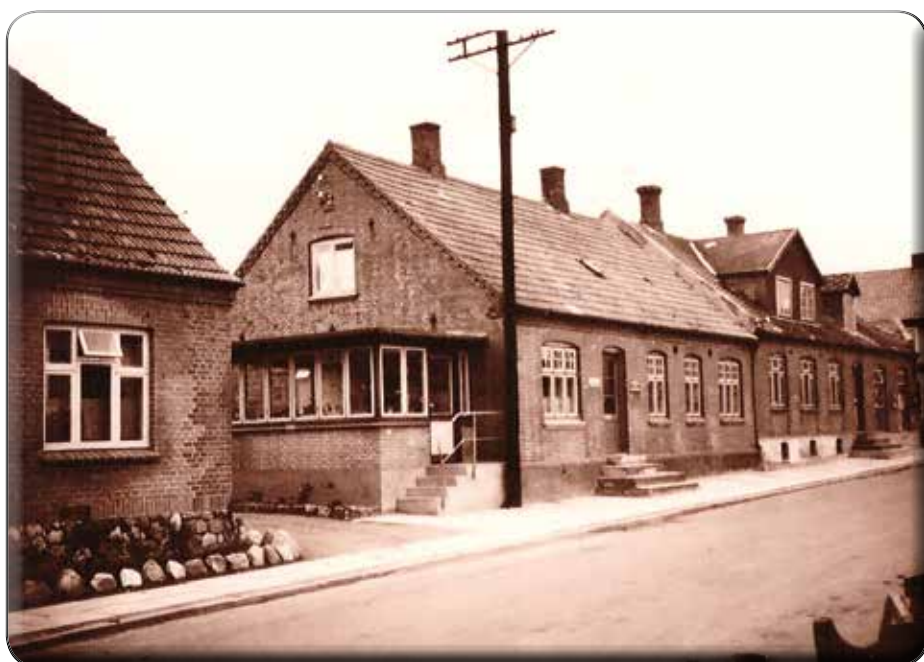
3. Vinderslevvej 29. Verandaen er bygget til. På hver side af døren er der et skilt. Det ene henviser til centralen. Det andet viser et skilt for arbejdsgivernes ulykkesforsikring, som min far var assurandør for.
