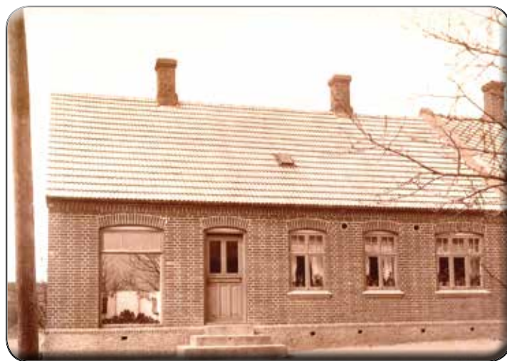
2. Vinderslevvej 29. Huset er bygget i 1906. Til venstre for døren er der skomagerbutik/værksted. Til højre for døren er stuen, hvor det første centralbord blev opstillet.
