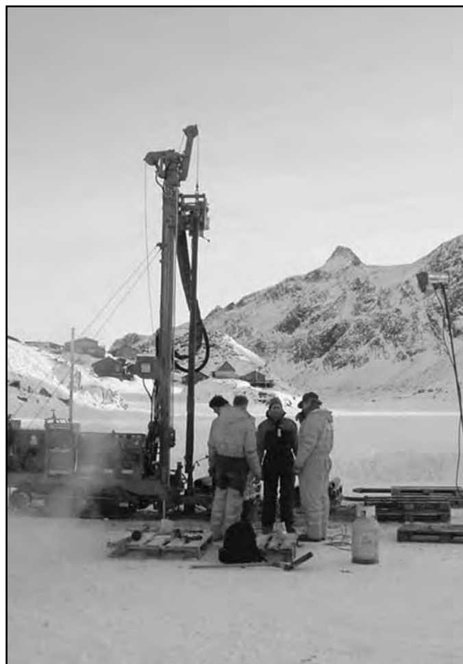
Borearbejde i Sisimiut en kold januardag for 10 år siden
