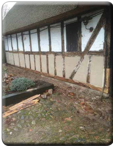
Udskiftning af bundrem. Opmuring og facadepuds på staldbygning
