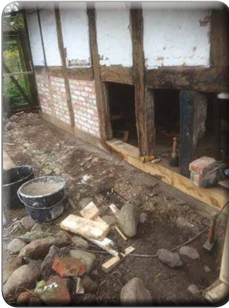
Udskiftning af bundrem. Opmuring og facadepuds på staldbygning
