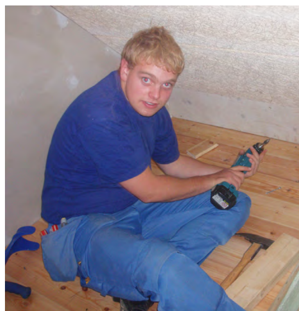
Thomas får de sidste gulvbrædder på plads
