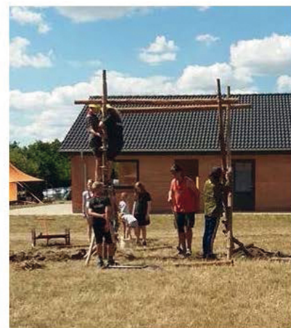
PÅ BILLEDET SES WINDIR SPEJDERE SOM ER I FULD GANG MED AT BYGGE
